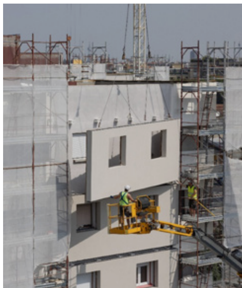
Il cantiere della riqualificazione
