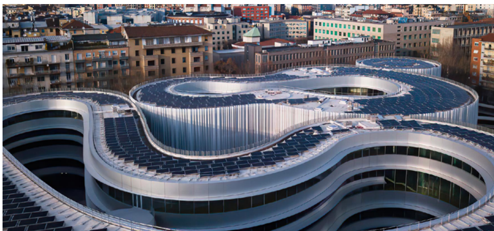
Sistema di pannelli fotovoltaici applicati sui tetti del nuovo campus dell'Università Bicconi a Milano.
