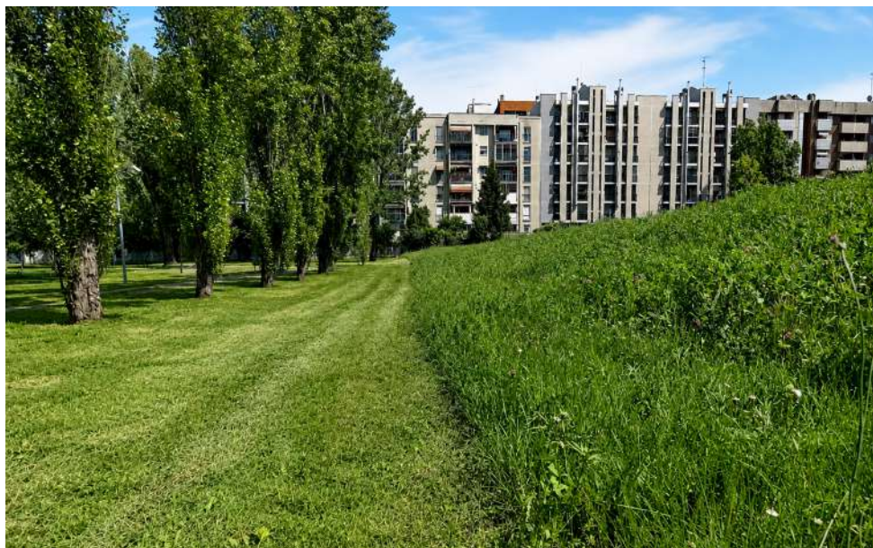
Area a sfalcio ridotto utile a trattenere l'acqua piovana e contrastare il calore
